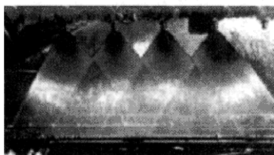
Распределение вяжущего (фото)
